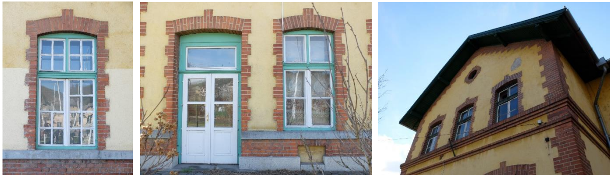
A Vasútállomás fogadóépületének archaizáló felújítása, eredeti nyílászárók megújítása
