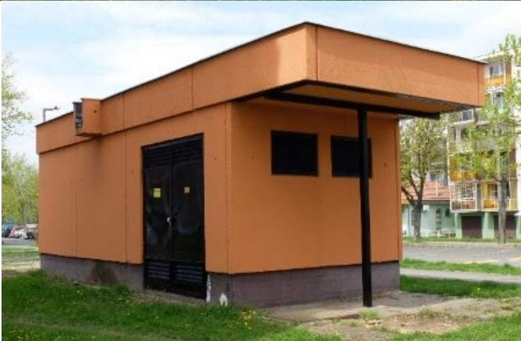
Trafóház egységes, letisztult felújítása – Újváros tér
