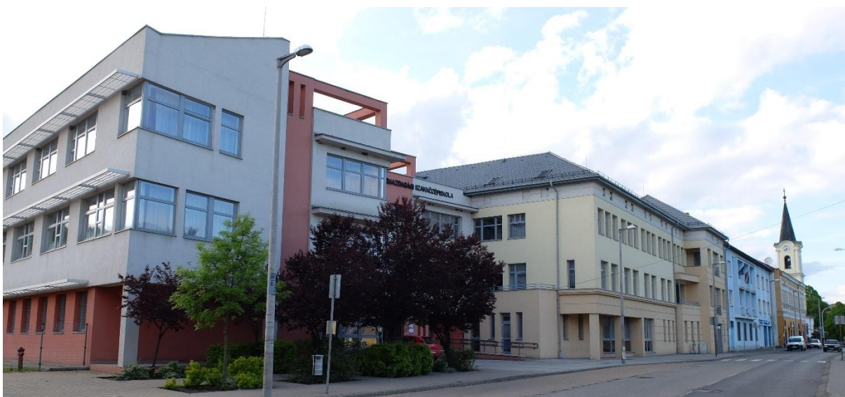
Zártsorú szövetbe illesztett modern épületegyüttes harmóniája
