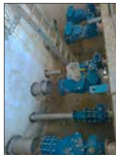
A bolyki tároló záraknája rekonstrukció után
